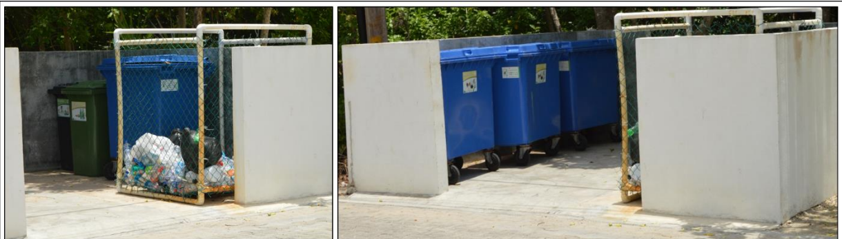
Estación receptora de residuos sólidos clasificados (Fotos 2206-2022)
