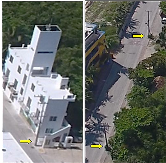
Tendido eléctrico aéreo con postes expuestos a daños por accidentes y por fenómenos hidrometeorológicos.
