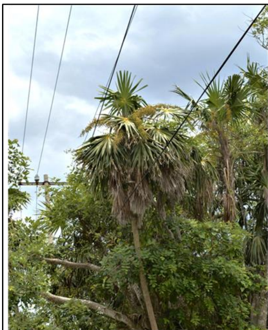
El contacto de las ramas con los cables produce "bajones" de voltaje que dañan equipos electrónicos como los controles de aires acondicionados.
